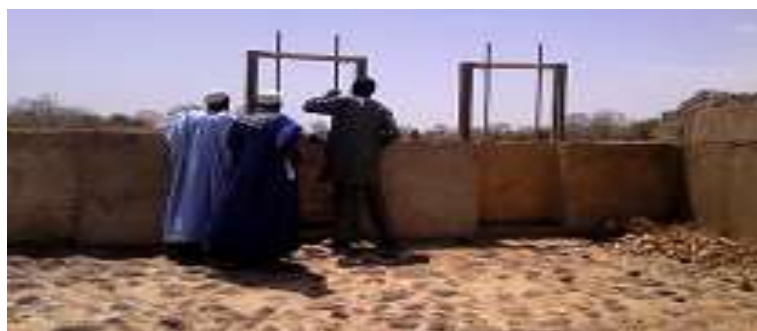
Barrage de Koussan
