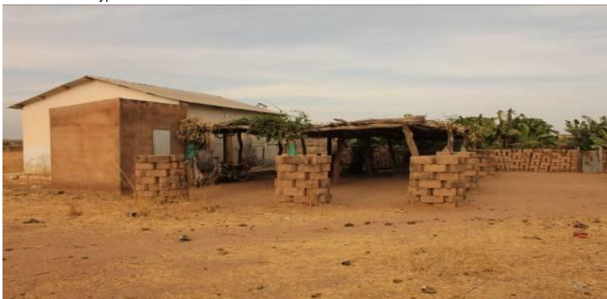
Photo 10 : Poste de sante de Talibadji (non clôturé)
