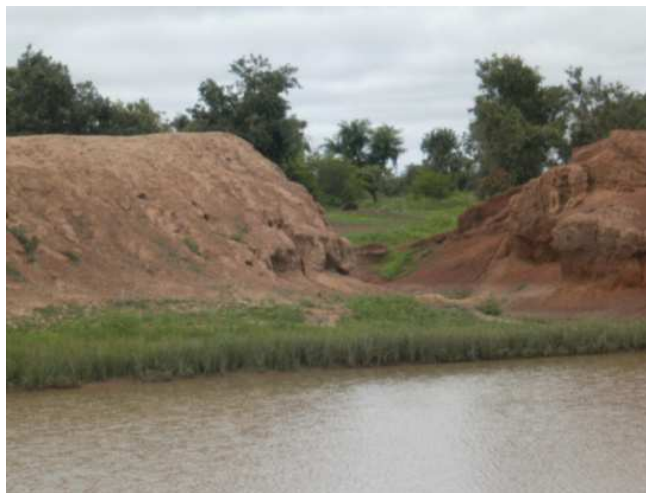
Figure 9: Digue barrage de Belly effondrée en 2009
